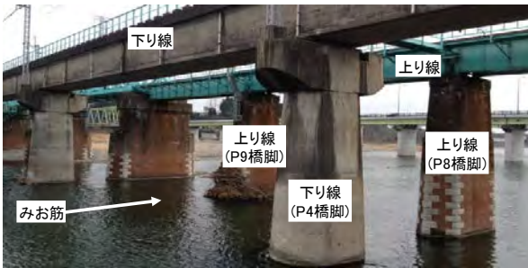
写真-1 対象橋脚
