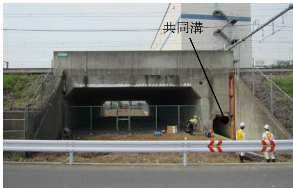
写真-1 現地状況
