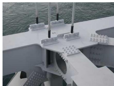
写真-2 ハンガー補修状況
