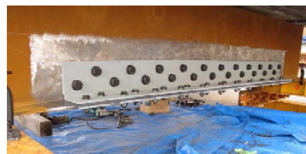
写真-1 試験施工状況
