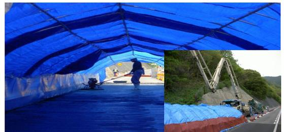
写真-3 上面施工(ドーム式養生)状況
