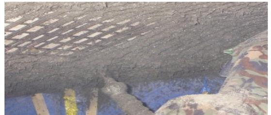
写真-2 下面増厚吹付け施工状況
