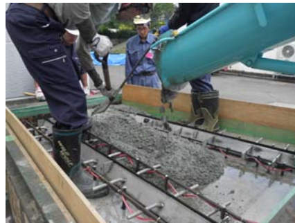
写真-6 コンクリート打設
