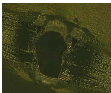
図 2 シリコンで生じたクラック
