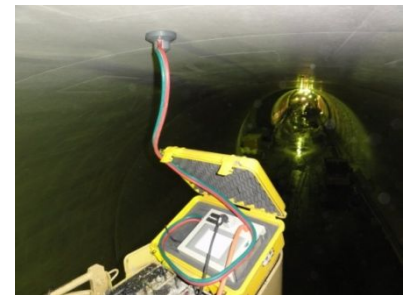
写真-2 透気試験状況
