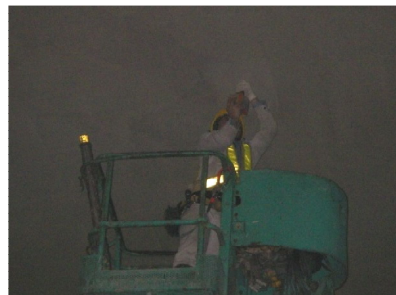
写真-1 強度測定状況
