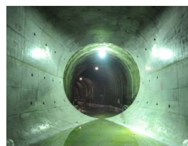
写真 4 特殊断面部全景
