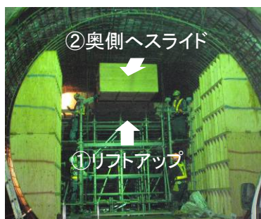
写真 2 天端型枠組立状況 (1)
