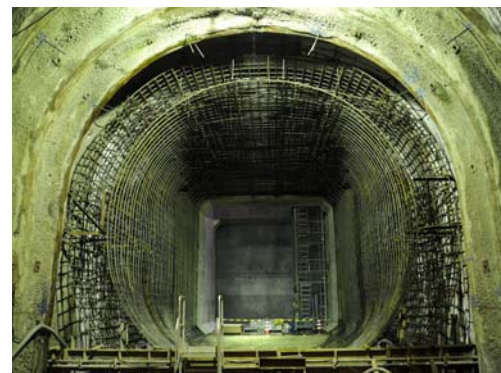
写真 1 特殊断面部配筋状況
