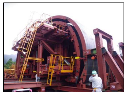
写真-1 セントル仮組み（くぐり抜け状況）
