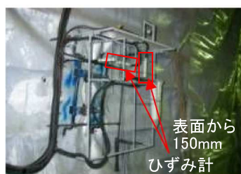
写真-3 埋設したひずみ計
