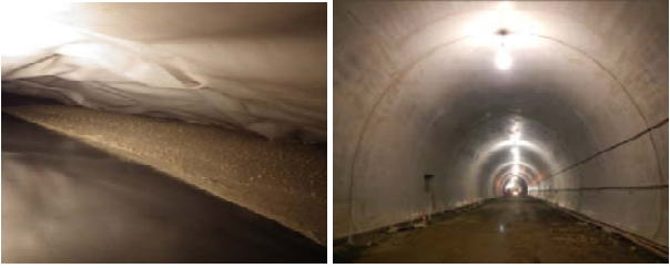
写真1 型枠バイブレータ締め固め後の状況(左)と覆工の仕上り状況(右)
