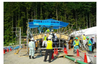
写真-1 打設状況
