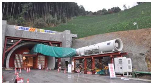
写真-3 坑口部の状況
