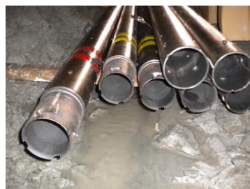
写真-2 ワンタッチ式継手
