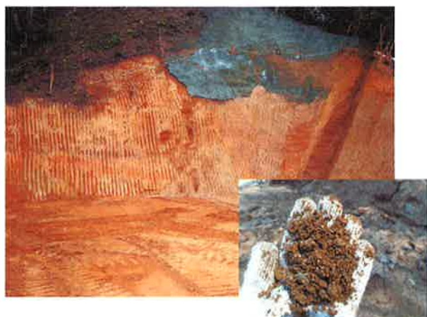
写真-1 坑口部の強風化層（マサ）
