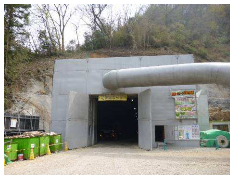
写真 1 コンクリート充填型（2層式）防音扉
