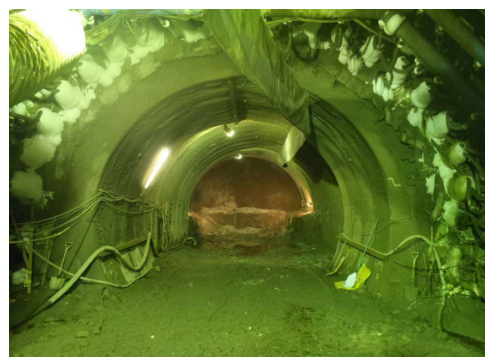
写真-1 凍結工法と横坑掘削状況
