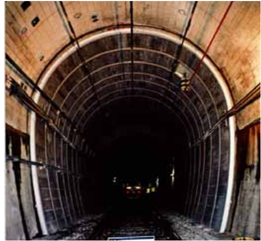
写真-1 対策工完成
