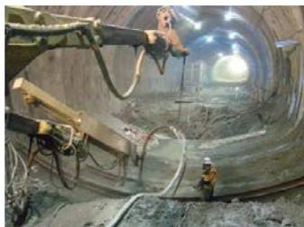
写真-3 インバートストラット吹付け状況
