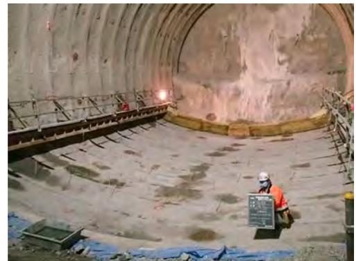
図-5 仮閉合吹付けインバート施工状況
