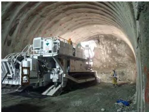
図-4 自由断面掘削機(300kw)による掘削状況
