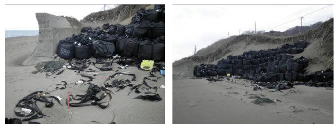
写真-3 応急対策後の第一工区の様子 (H25.3)
