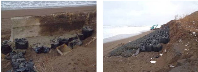
写真-2 第一工区の応急対策 (H24.12)
