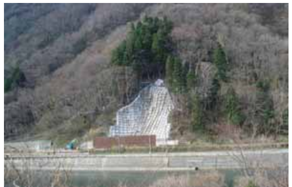
図9. 復旧工事完了後
