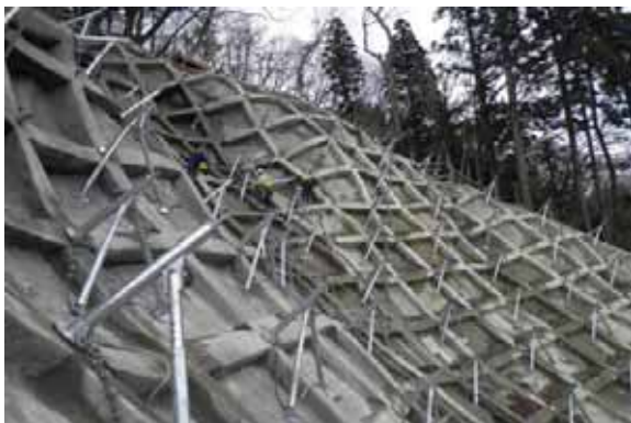
図6. 吹付け砕工・雪崩抑止杭
