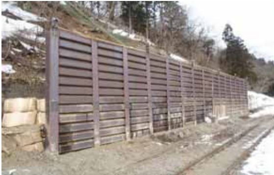
図5. 土砂留柵設置完了
