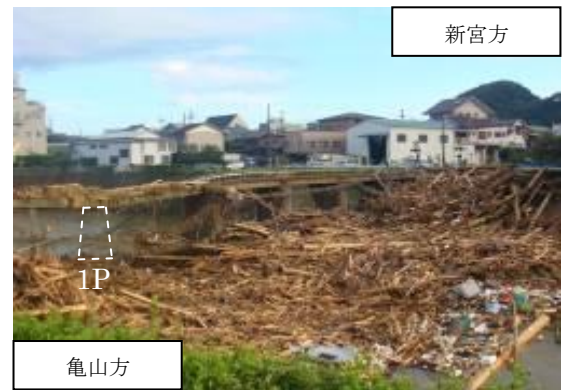
写真-1 井戸川橋りょう被災状況
