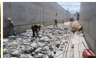
写真-8 撤去状況②
