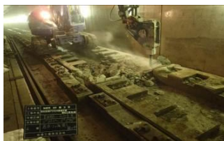
写真-7 撤去状況①
