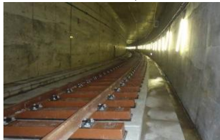
写真-9 施工後①
