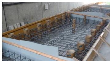
写真-5 箱抜き工法
