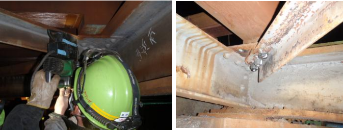
写真－4 リベット撤去 写真－5 対傾鋼端部 H・T・B 化
