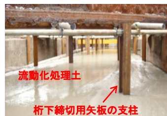
写真-2 流動化処理土
