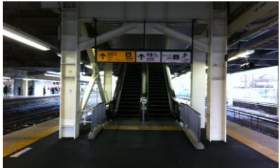
写真－3 エスカレーター新設
