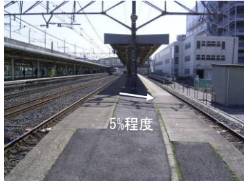
写真－6 施工前ホーム
