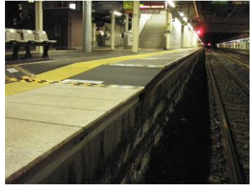
写真－5 仮設ホーム
