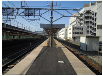
写真－7 施工後ホーム
