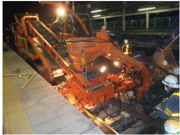
写真－4 軌道降下作業状況
