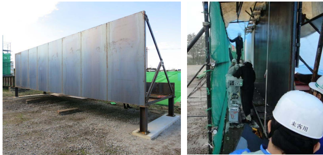
写真3 模擬箱桁(左)と模擬足場(右)
