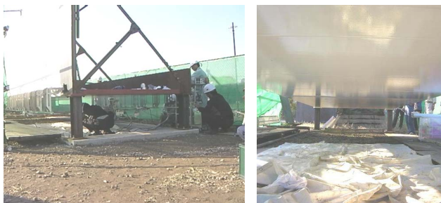
写真5 桁下面の施工状況(左)と形成塗膜(右)
