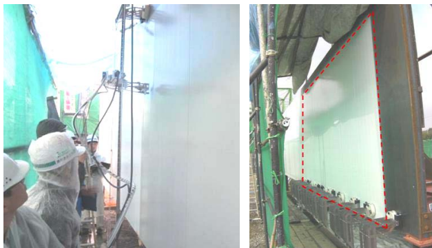
写真4 桁側面の施工状況(左)と形成塗膜(右)
