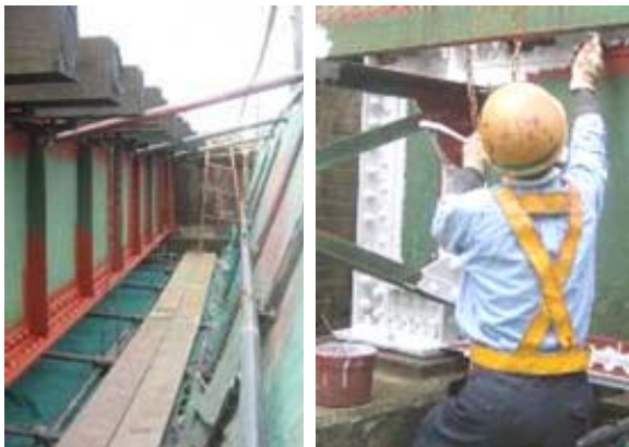
写真1 吊り足場(左)と人力塗装作業(右)
