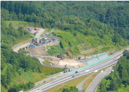
写真-1 工事現場全景
