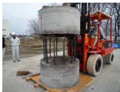
写真 - 6 杭頭処理部の切り離し
