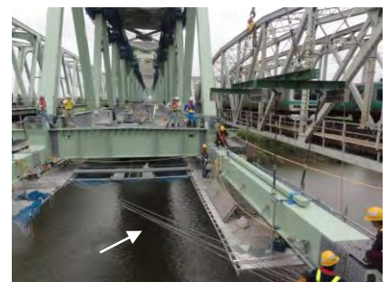
写真-1 桁通り調整
