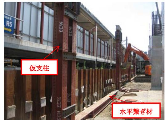
写真-1 R5仮支柱施工写真
