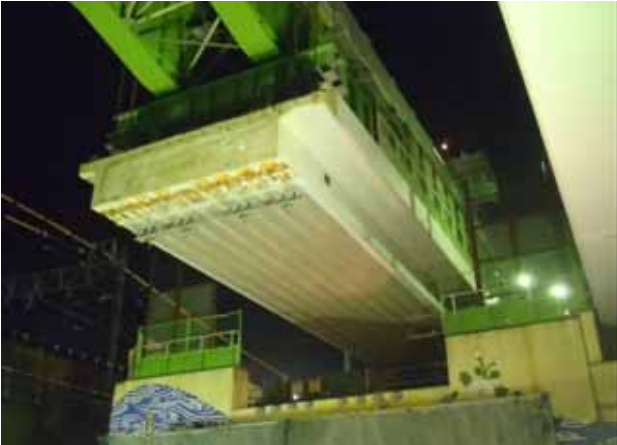
写真-3 撤去状況
