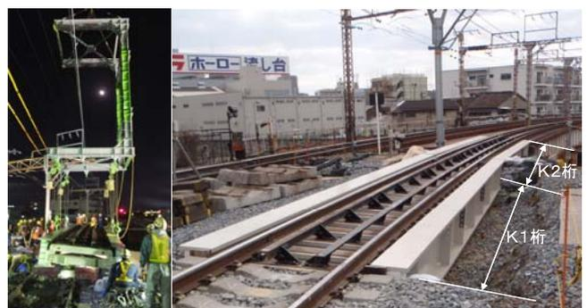
写真-2 K2桁架設状況、工事桁架設完了
