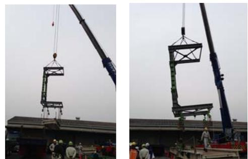
写真-1 試験吊り実施状況
