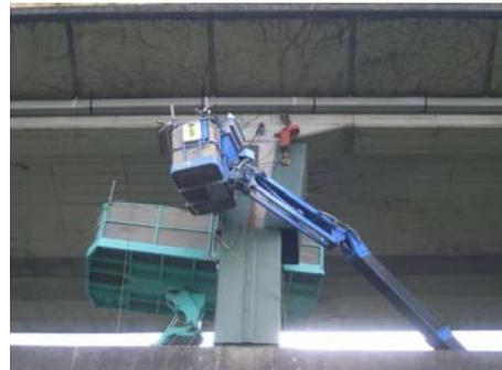
写真 4.2 下段部鋼板設置状況
