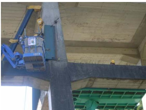
写真 4.1 下段部鋼板設置状況
