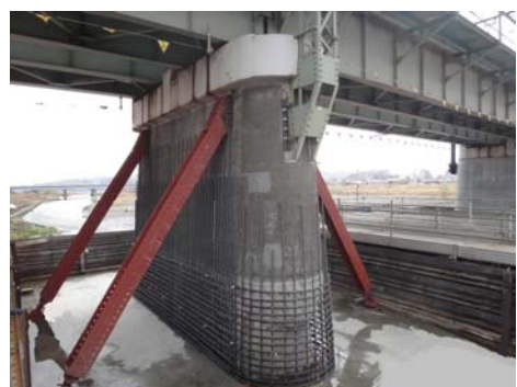
写真1 施工状況(フーチング打設完了時)
