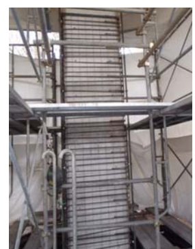
写真-1 鉄筋巻立完了
