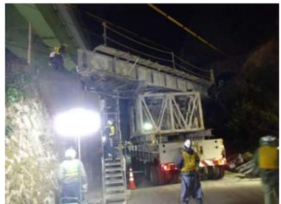
写-3 新設桁運搬・架設状況
