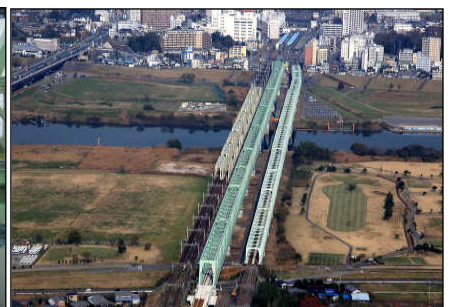
トラス桁架設完了(全景)
