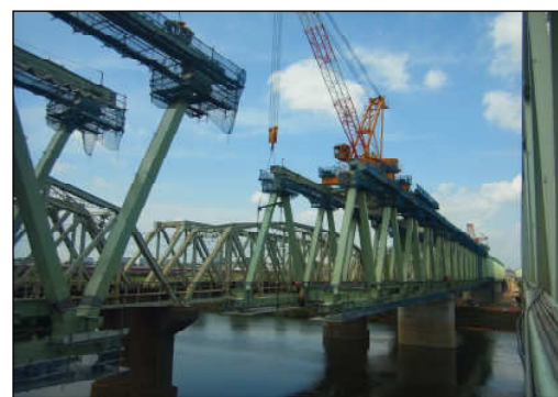
トラベラークレーンによる張出架設
