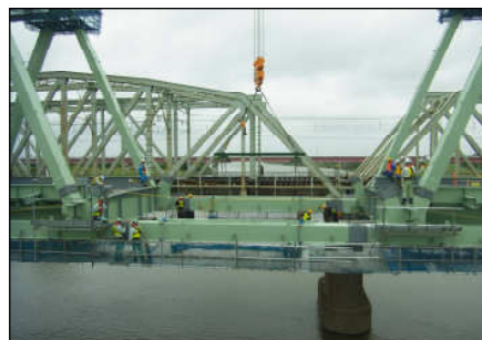
下弦材落とし込み閉合
