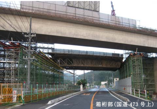
写真-2 固定式支保工横移動状況（移動完了時）
