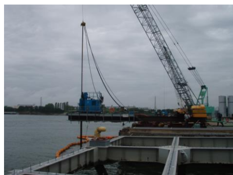
写真-2 施工状況（最大張り出し）
