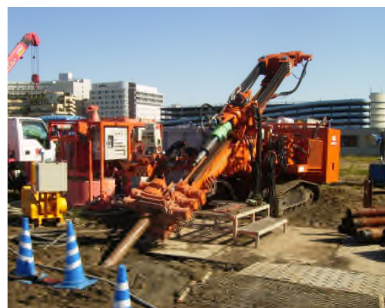
写真-1 施工状況
