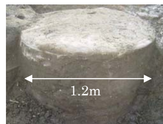
写真-1 改良体上部の状況
