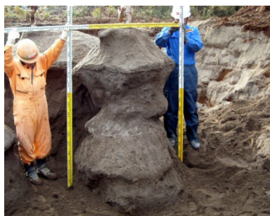
写真 2 改良状況 (No.1)
