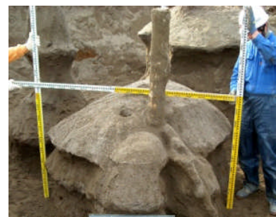
写真 3 改良状況 (No.2)
