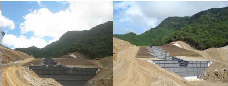
写真-1 吹付けから 1 か月経過後の植生状況
