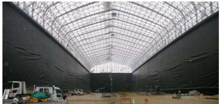
写真-2 ハンガー式遮水工の施工状況
