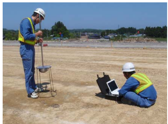
写真1 落球探査法による測定状況
