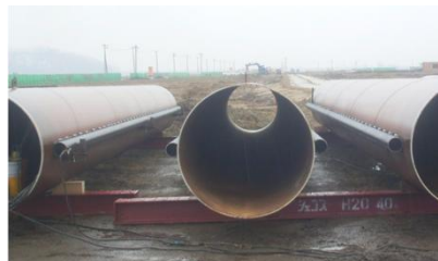
写真-1 炭素鋼鋼管を溶接した試験杭
