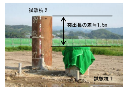
写真-2 施工後の試験杭の状況
