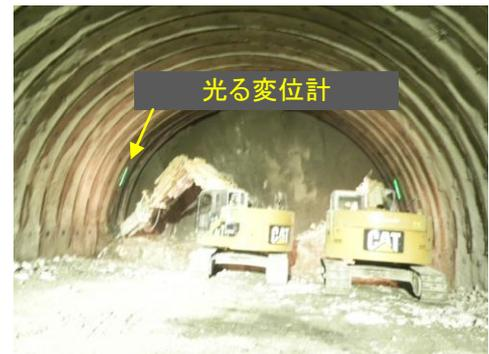
写真-1 光る変位計設置状況
