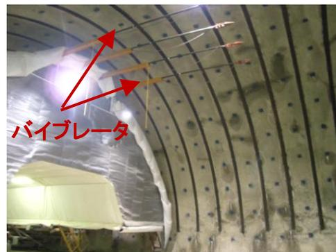
写真-5 長尺バイブレータ（引抜き状態）
