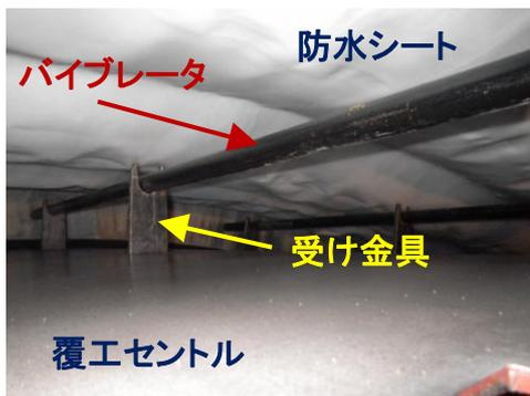
写真-4 長尺バイブレータ設置状況（セントル内部）
