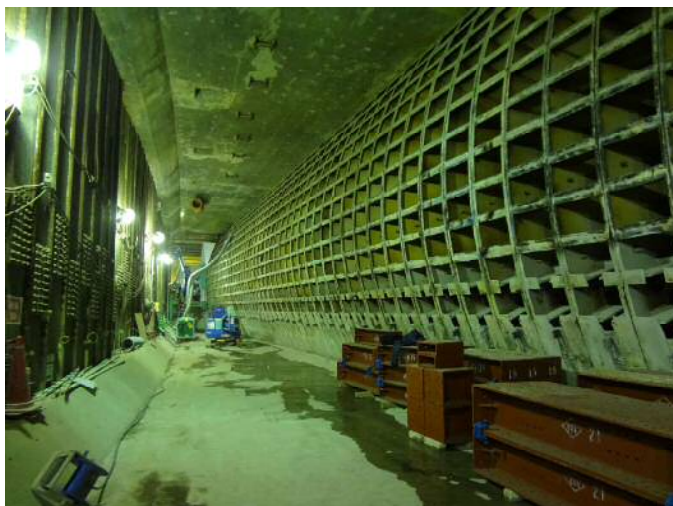
切り開き前（スキンプレーート撤去後）
